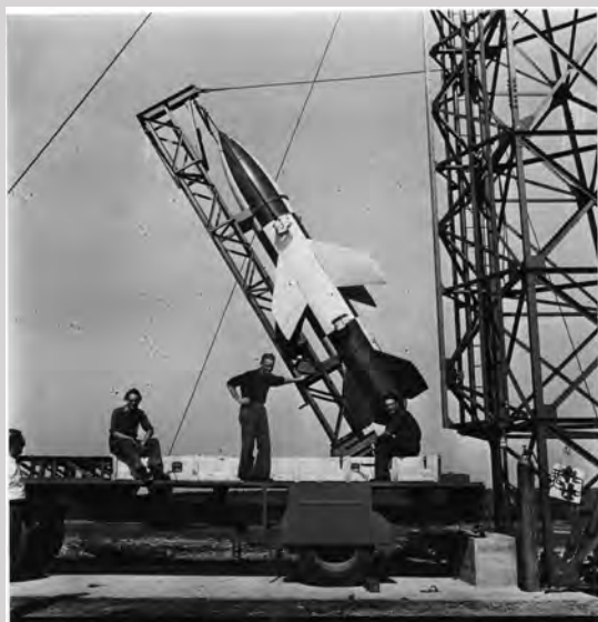
SE 4100 1ère fusée française moderne (1er vol 29.9.49), grand-mère d'Ariane : banc d'essai architecture latérale/tandem, propulsion liquide/solide, guidage/pilotage sur faisceau, autodirecteurs électromagnétique/optique, récupération (16 versions) @ Collection Ph. Jung
